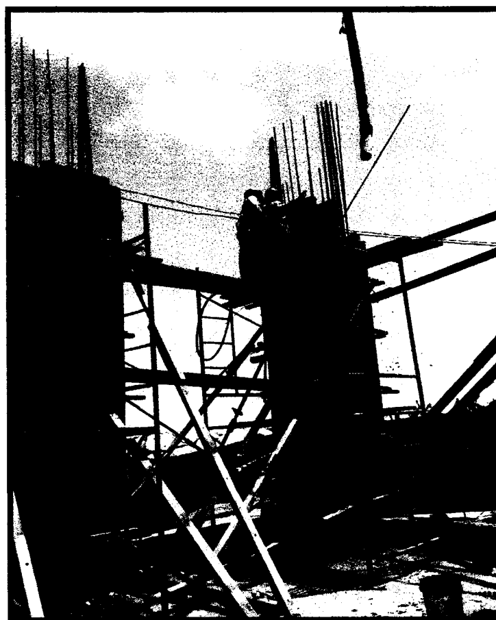
FOTOGRAFIA 12: Encofrado de columnas, placas y vaciado de concreto en área de fríos.
