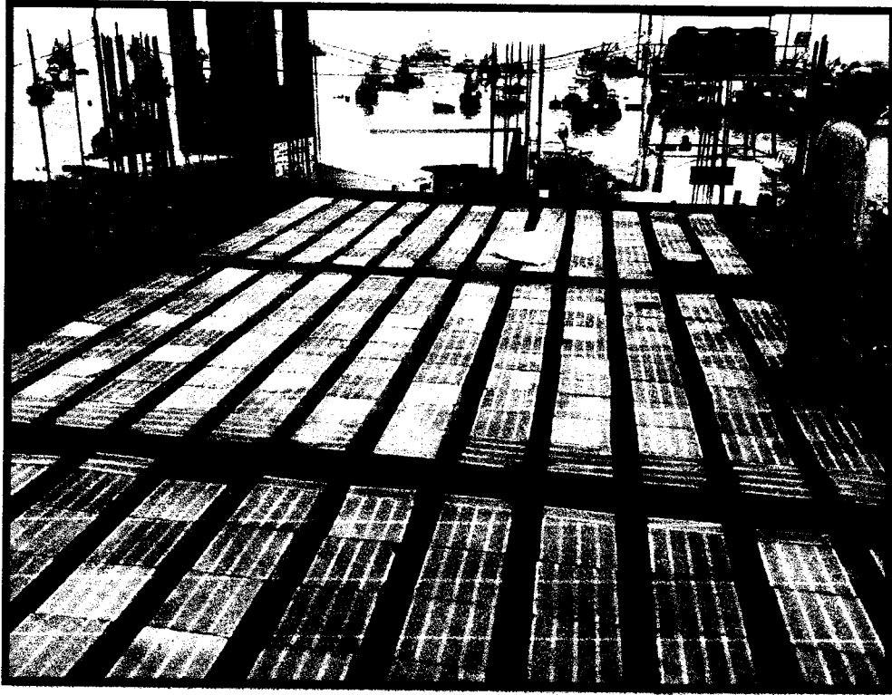
FOTOGRAFIA 19: Losa aligerada en área de frios.
