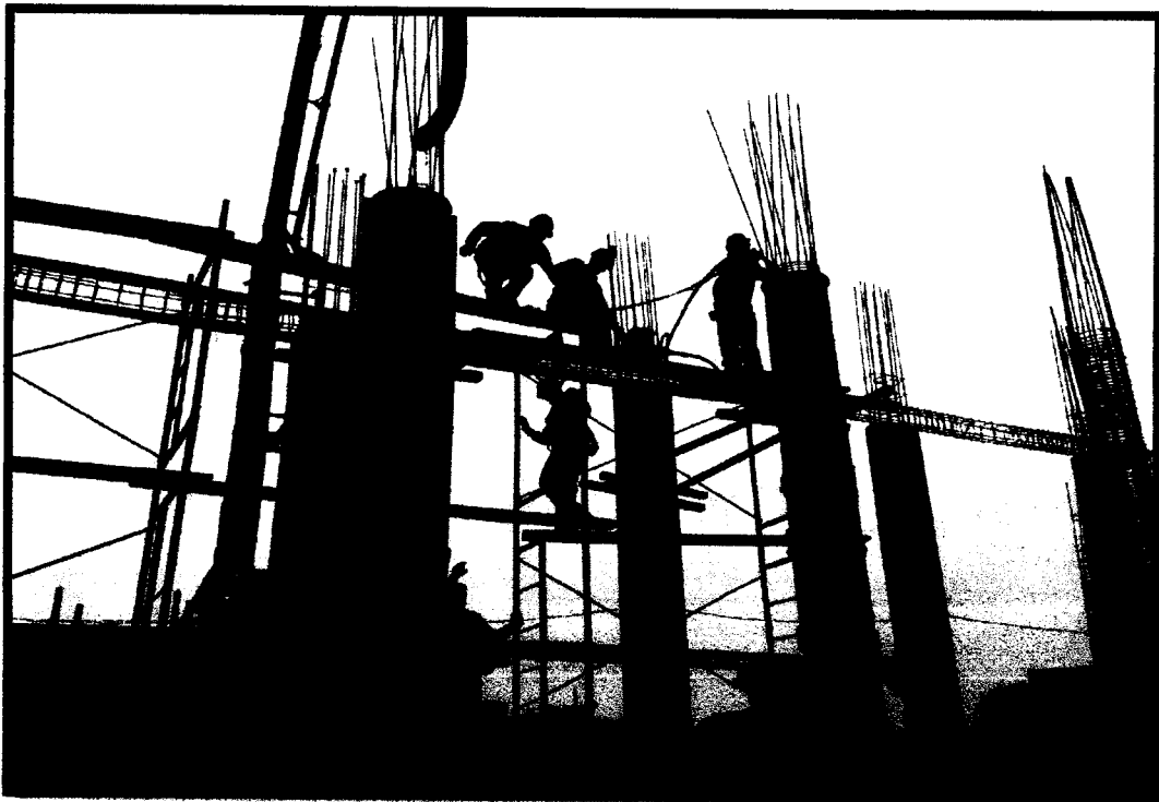
FOTOGRAFIA 02: vaciado de concreto en columnas en Tareas previas.
