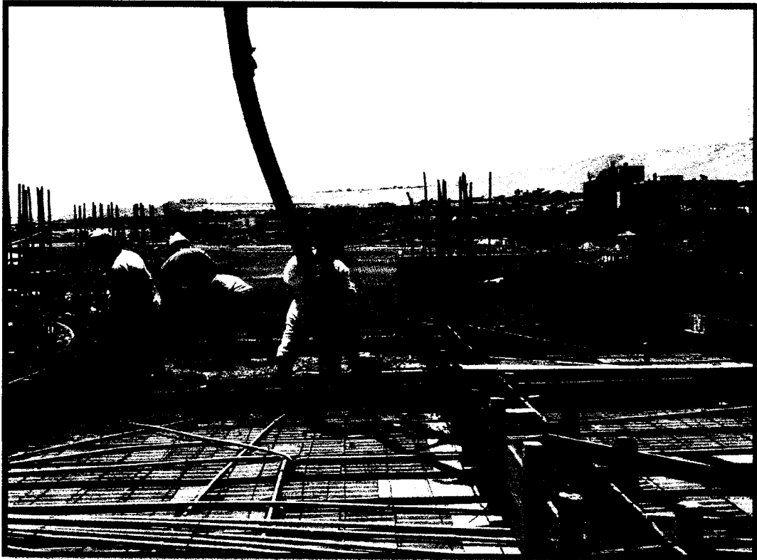
FOTOGRAFIA 10: concreto en losa aligerada de tareas previas con instalaciones eléctricas y sanitarias.
