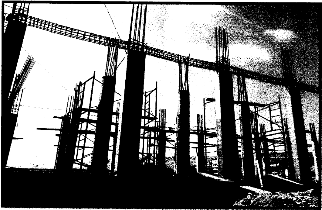
FOTOGRAFIA 03: Columnas en tareas previas.
