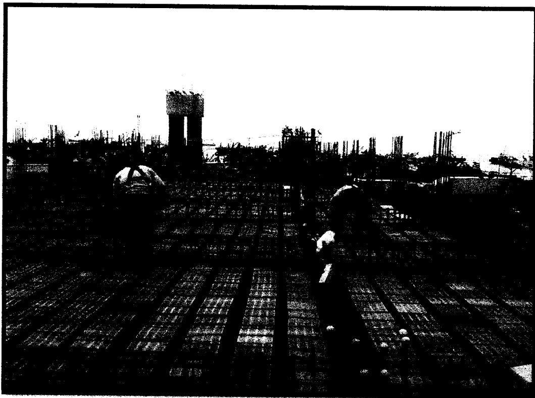
FOTOGRAFIA 06: colocado de acero en vigas y acero en tareas previas.
